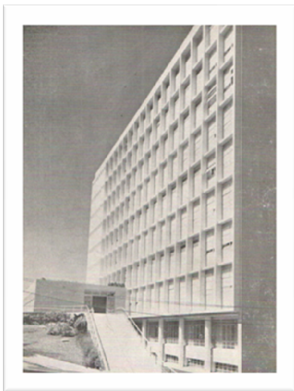
Fig. 10. Foto do prédio da Faculdade de Odontologia da Universidade da Bahia. Em 1958 instalou-se em seu novo prédio, no Campus Universitário. Cf. Publicação editada pela Universidade da Bahia por ocasião do IV Colóquio Internacional de Estudos Luso Brasileiros. (Contracapa).
